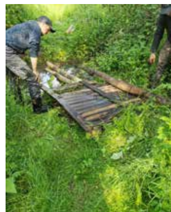
Création de passerelles à la réserve naturelle de Wadelincourt
