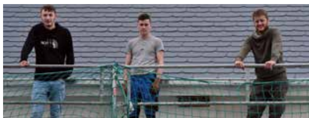
Un ouvrier et deux stagiaires du PNPE pour assurer la pose des nichoirs et planchettes sur quelques façades de la cité à Roucourt
