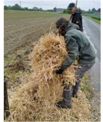
Pose de fascines anti-érosives à Willemeau
