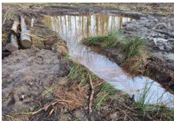
Travaux de restauration d'une zone humide à Wiers
