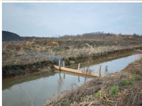
Sur le site du nouveau terail Billemont à Antoing, création d'un bassin avec îlot de reproduction pour oiseaux limicoles et de noues dotées de 28 moines (petits barrages) favorables au Crapaud calamite.
