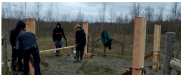
Construction d'un abri pour l'éco pâturage dans les landes à Callune du côté de Maubray
