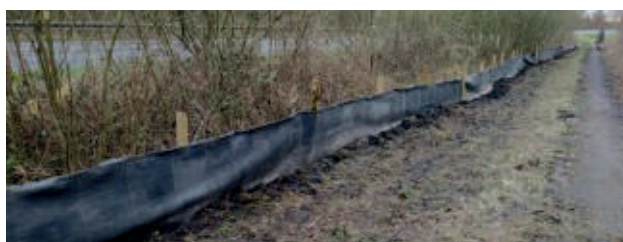
Installation d'un barrage    batraciens sur la N506    Blaton, pour la premi  re fois, afin de quantifier les populations d'amphibiens
