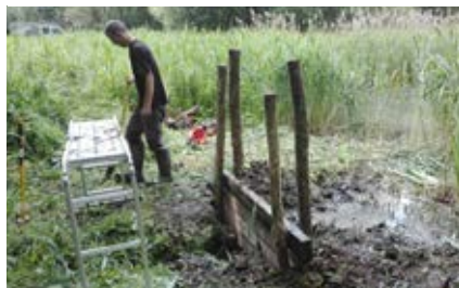
Roucourt - Pose d'un moine pour maintenir le niveau des eaux d'une roselière
