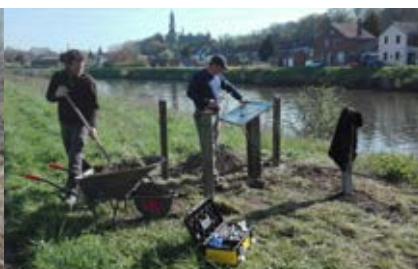
Antoing - Pose d'une pierre de lave le long de l'Escaut canalisé
