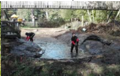
Bon-Secours - Restauration de la mare de la Maison du PNPE
