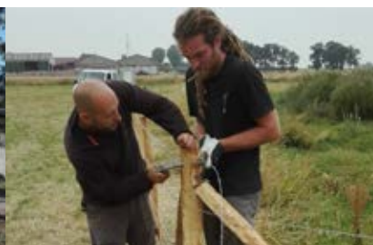
Quevaucamps - Pose d'un clôture à bétail autour d'une mare creusée
