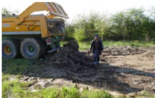
Pose d'argile d'étanchéité dans une mare du Life Carrières
