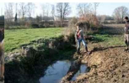
Station d'épuration - Roucourt
